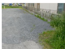
駐輪場屋根 CD 駐車場
